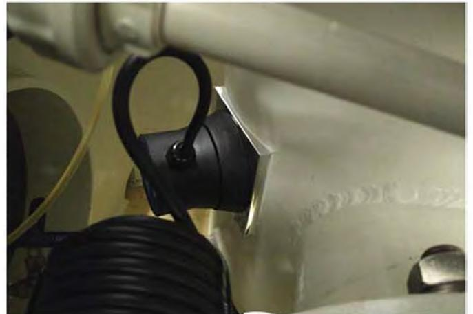
トランスデューサーを取り付ける前に、エポキシを完全に硬化させます。
